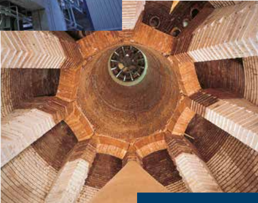
Tino dei forni Maerz
